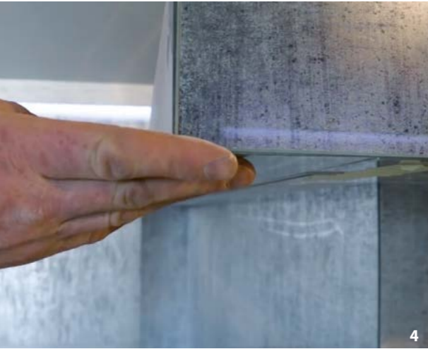
Silicone tradizionale per applicazione e stuccatura su pareti in compensato
