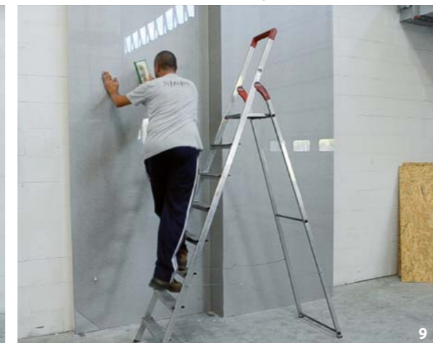
Installazione lastre · Slabs installation
